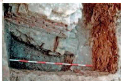
Sonda č. 1 Horizontálny pohľad na tehlové murivo oporného piliera (múr č. 3) s pieskovcovým základom z východnej strany.
